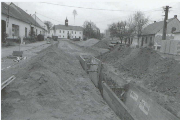
Obr. 116: Vémysllice. Celkový průběh výkopu kanalizace na návsi obce. Abb. 116: Vémysllice. Verlauf des Grabens für Kanalisierung auf dem Dorfplatz.
