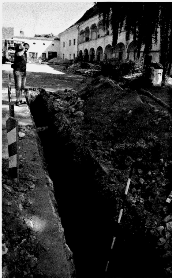
Obr. 142. Slatina. Pohled na zámecké návrší s trasou výkopu v místě nálezu středověkých sklepů. Slatina. Blick auf den Schloßberg mit der Grabenslinie in der Stelle der angeschnittenen Keller.
