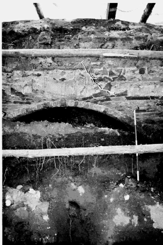
Obr. 95. Tuřany, jezuitská rezidence. Detail zavaleného sklepení.
