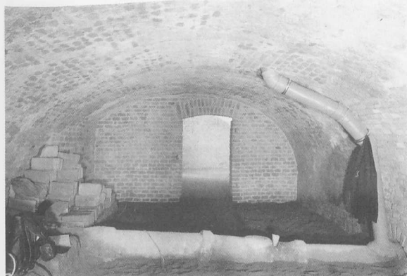
Obr. 2. Blok 40 (A057/2002). V sondě F1 objevený sklep.
