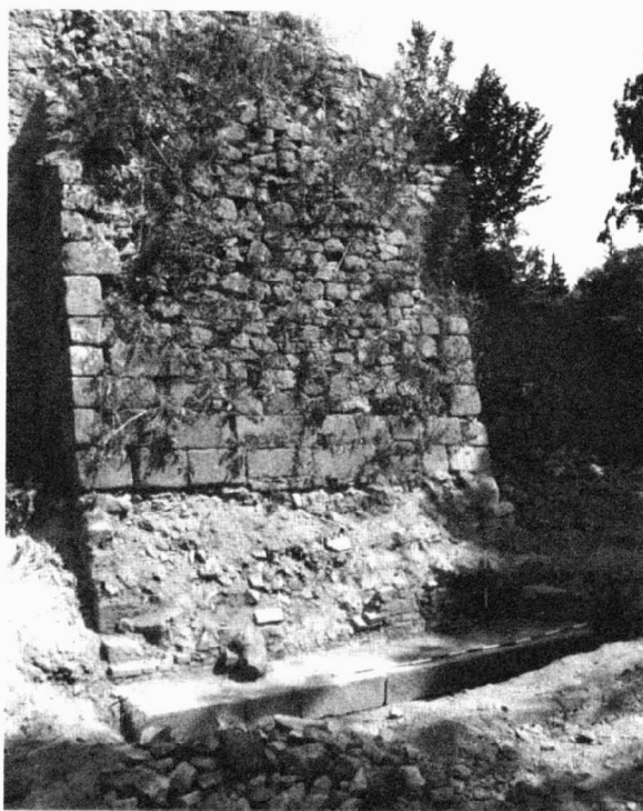
Obr. 19. Hrad Lukov – nově objevená hranolová stavba pod základy barokního pilíře v západním parkánu.
