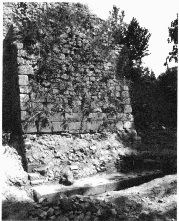
Obr. 19. Hrad Lukov – nově objevená hranolová stavba pod základy barokního pilíře v západním parkánu.
