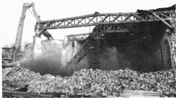
Obr. 58. Ulice Trnitá, areál továrny Vaňkovka (A114/2003). Demolice továrních budov. Trnitá-Straße. Fabrikareal Vaňkovka (A114/2003). Demolition der Fabrikgebäude.
