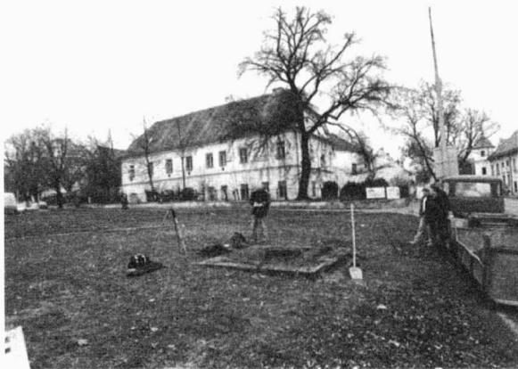
Obr. 61. Mojžírovo náměstí (A117/2003). Výkop pro betonový základ kříže.
