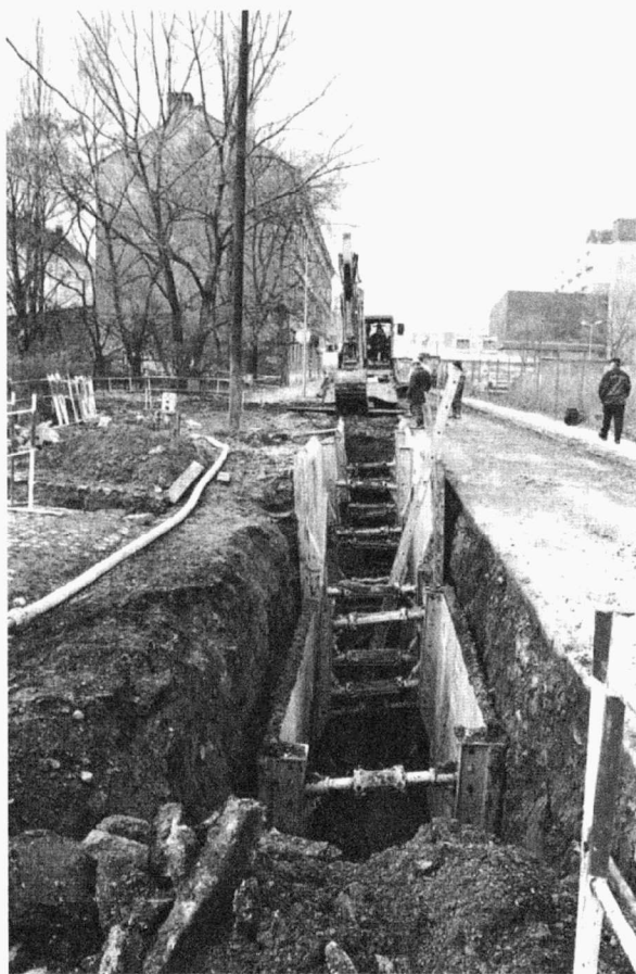
Obr. 33. Ulice Trnitá (A021/2003). Celkový pohled na výkop kanalizace od severu. Trnitá-Straße (A021/2003). Gesamtansicht des Kanalisationsaushubs vom Norden.
