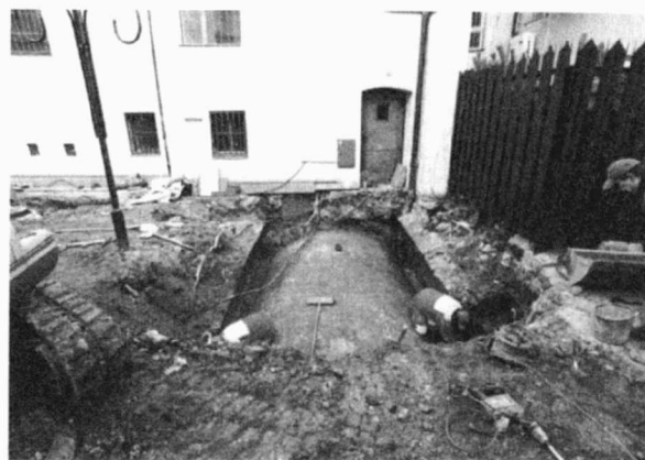
Obr. 54. Ulice Radnická (A107/2003). Odhalená klenba sklepa. Radnická-Straße (A107/2003). Freigelegtes Kellergewölbe.
