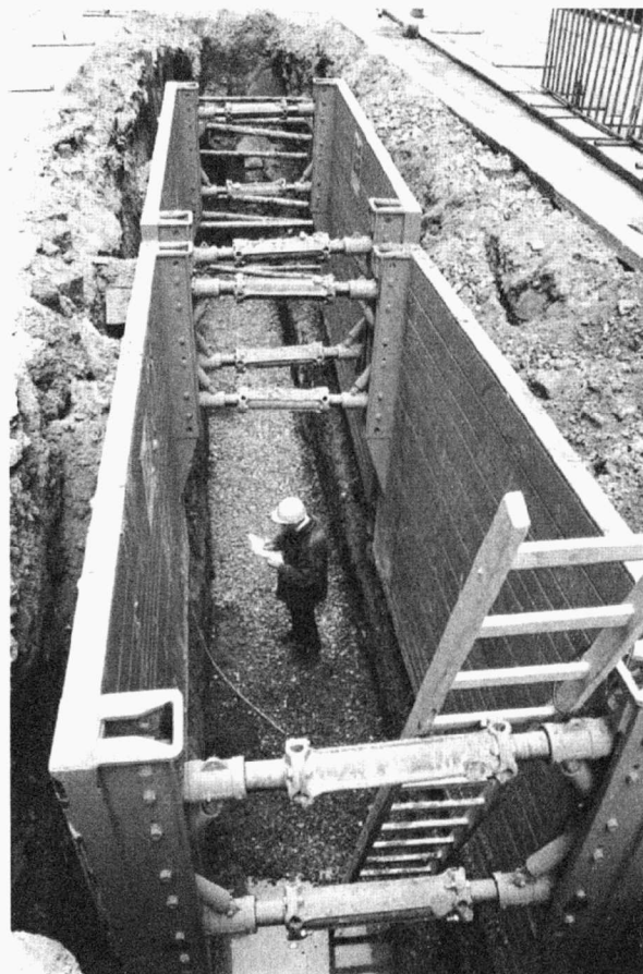
Obr. 42. Ulice Běhounská (A070/2003). Dokumentace nalezených situací. Běhounská-Straße (A070/2003). Dokumentation der entdeckten Situationen.
