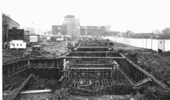
Obr. 52. Ulice Trnitá (A101/2003). Celkový pohled na výkop kolektoru. Trnitá-Straße (A101/2003). Gesamtansicht des Aushubs für den Kollektor.
