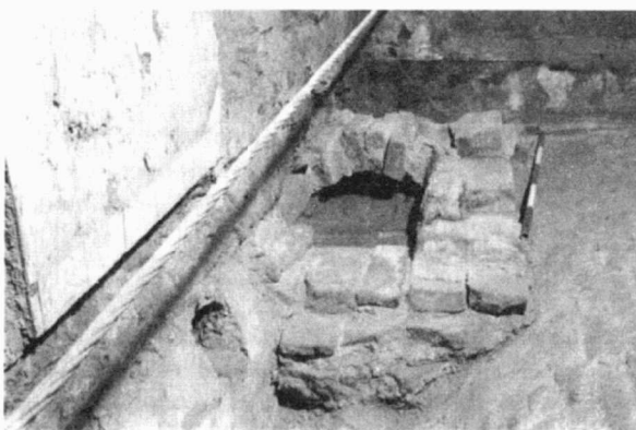
Obr. 9. Mečová 4 (A102/2001). Základ kachlových kamen v černé kuchyni 2NP. Mečová Gasse Nr. 8 (A102/2001). Grundmauer vom Kachelofen in der schwarzen Küche.
