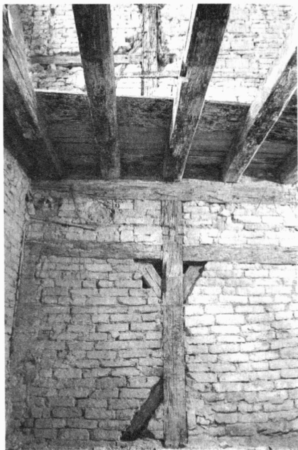
Obr. 13. Mečová 8 (A172/2001), odkrytá hrázděná konstrukce v I NP. Mečová Gasse Nr. 8 (A172/2001), entdecktes Fachwerk im I. oberirdischen Stock.
