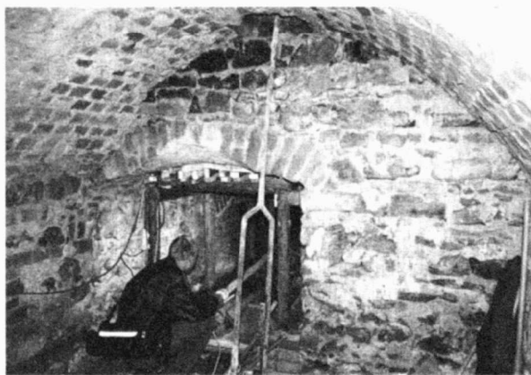
Obr. 34. Blok 43 (A48/2002), pozdně gotický sklípek odkrytý v sondě A4.
