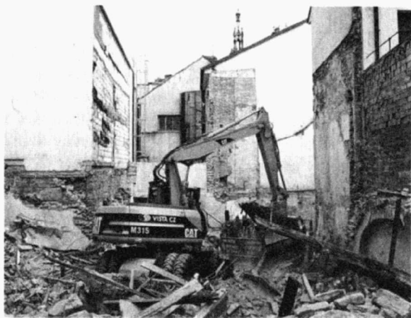
Obr. 36. Česká 10 (A56/2002), průběh bourání kulturní památky v centru MPR Brno. Česká 10 (A56/2002), Demolierungablauf.
