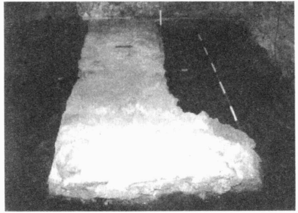
Obr. 23. Olomouc – Wurmova ul. č. α 1. Celkový pohled na zdivo k. 900 od východu.
