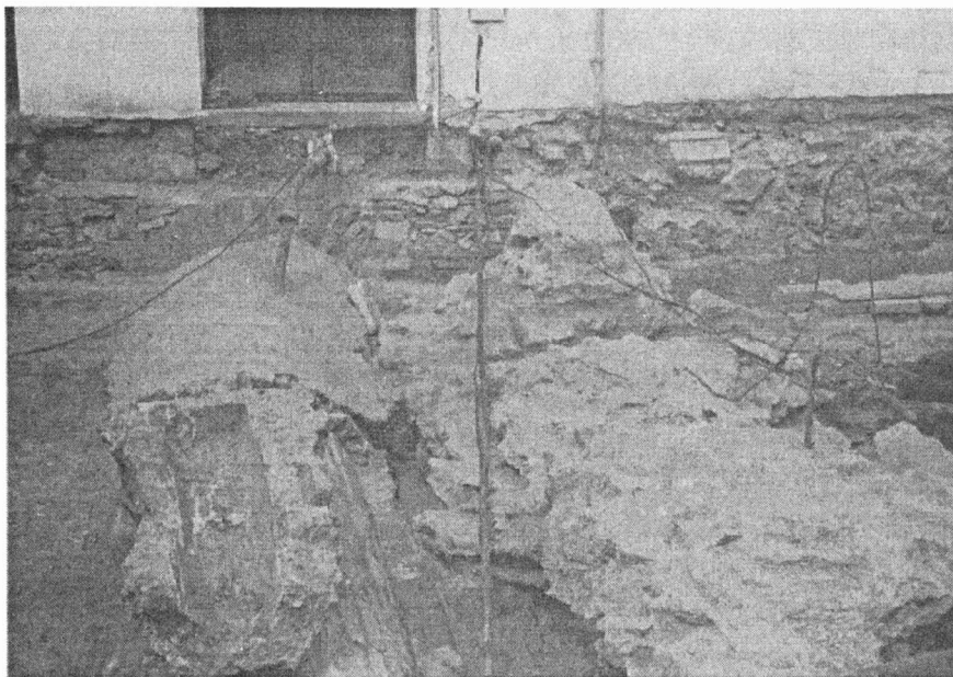
Obr. 4. Detail základu vnitřní zdi kostela Panny Marie (Foto J. Kovárník)
